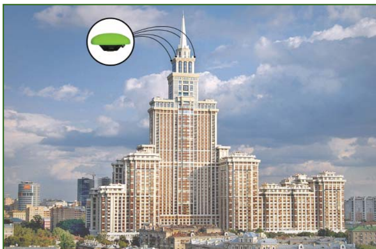
Рис. 1 Места установки антенн ГНСС компании JAVAD GNSS на здании «Триумф Палас»
